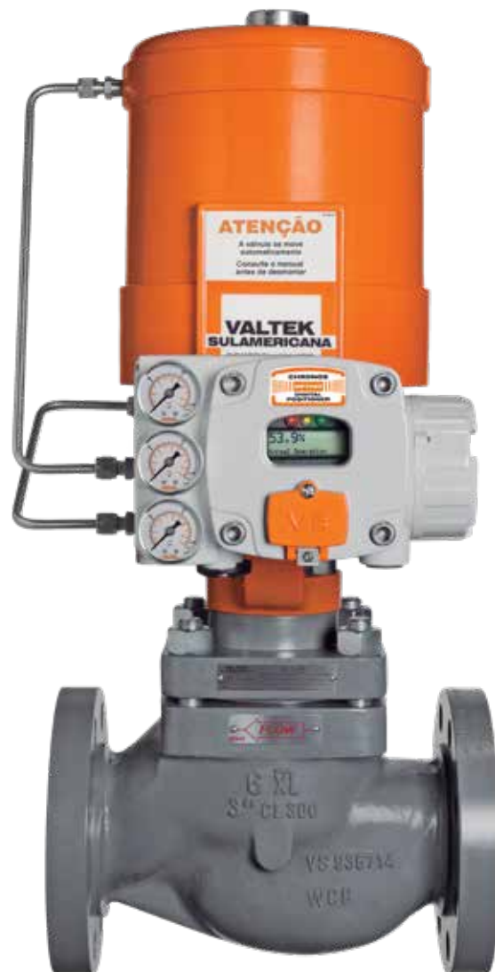
Figura 1: Posicionador Chronos instalado em Válvula Globo ValtekSul
